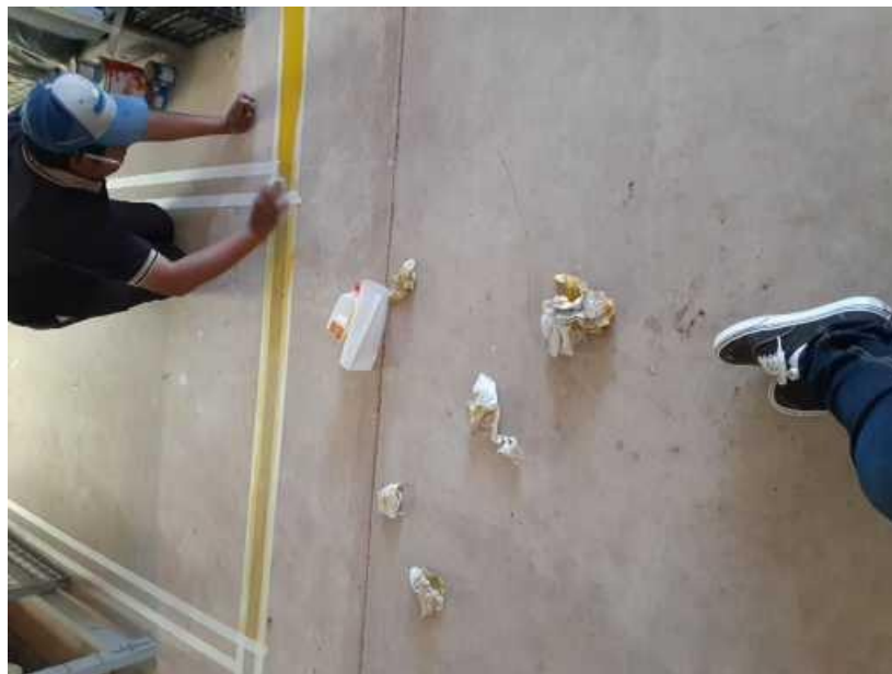
Fotografía 23 Delimitación del área del patín. Fuente; Propia
