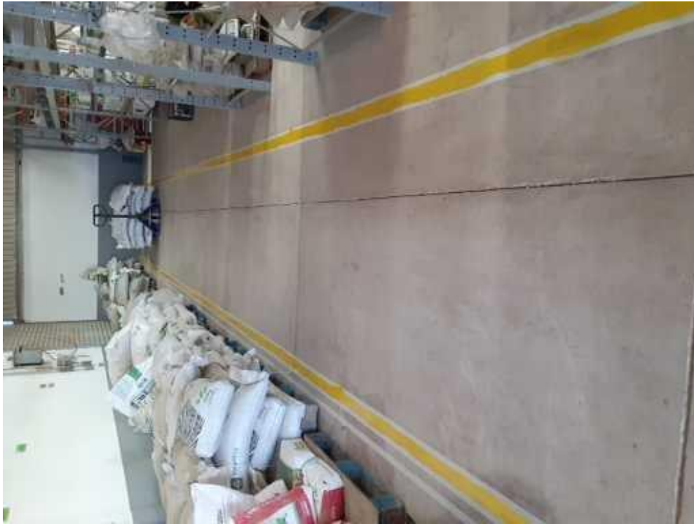
Fotografía 24 Delimitación del área del almacén. Fuente; Propia
