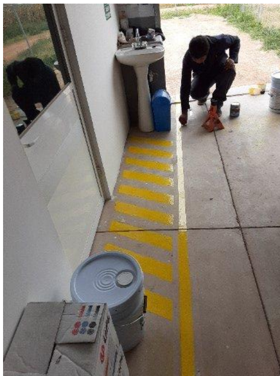
Fotografía 27 Delimitación para pase del personal. Fuente; Propia
