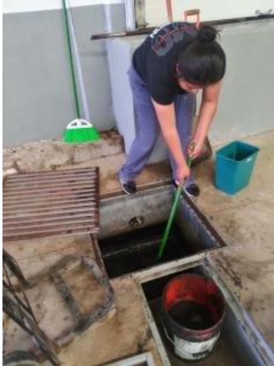
Fotografía 3 Limpieza y sacado de desechos de la rejilla del desagüe. Fuente; Propia
